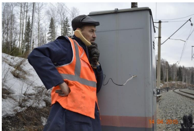
Рисунок 1 – Электромеханик связывается с ДСП ближайшей станции по ПГС
