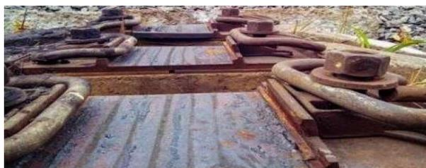
Рисунок 1 - Характерные повреждения подкладок скрепления
