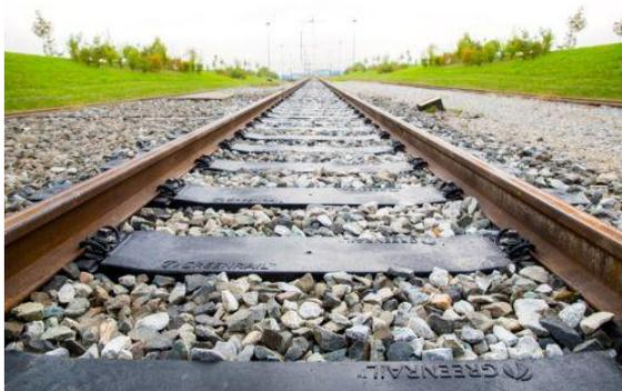
Рисунок 1 - Рельсы с солнечным зарядом
