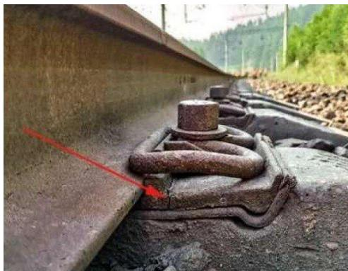
Рисунок 2 - Скрепление ЖБР-65ПШМ с лопнувшей подкладкой
